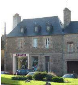
Construction en schiste et granit et toiture 4 pans en croupe
