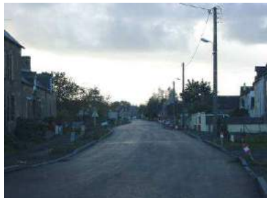
RD 155 : Séquence 2 : Entrée déstructurée, voie
