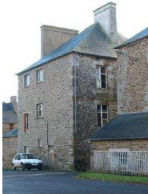
Construction en schiste et granit et toiture 4 pans en croupe
